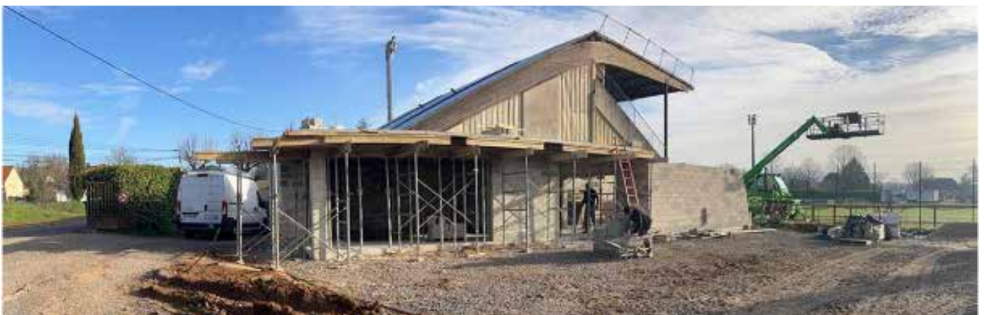
Extension vue depuis stationnement
