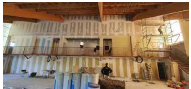
Vue d'ensemble depuis dojo : doublage mur rez-de-chaussée, cloisonnement
