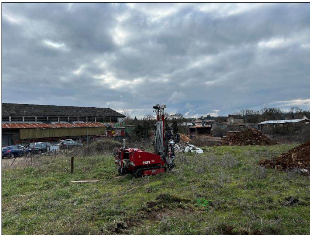
Figure 17 Réalisation des sondages au pénétromètre statique-dynamique 150 kN le 08/01/2024.
