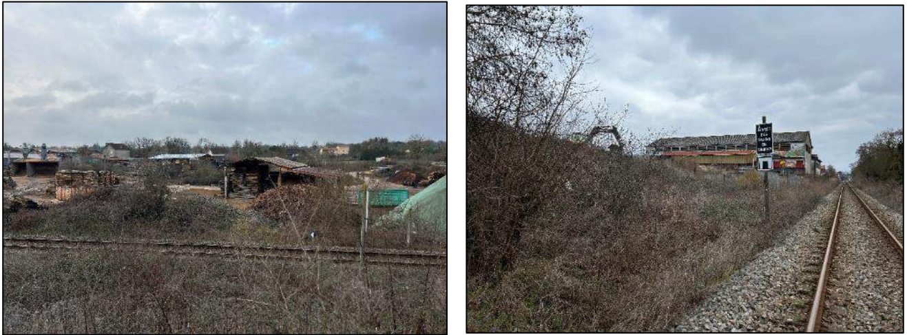
Figure 6 Vues sur la voie ferrée en contre-bas de la parcelle - 08/01/2024
