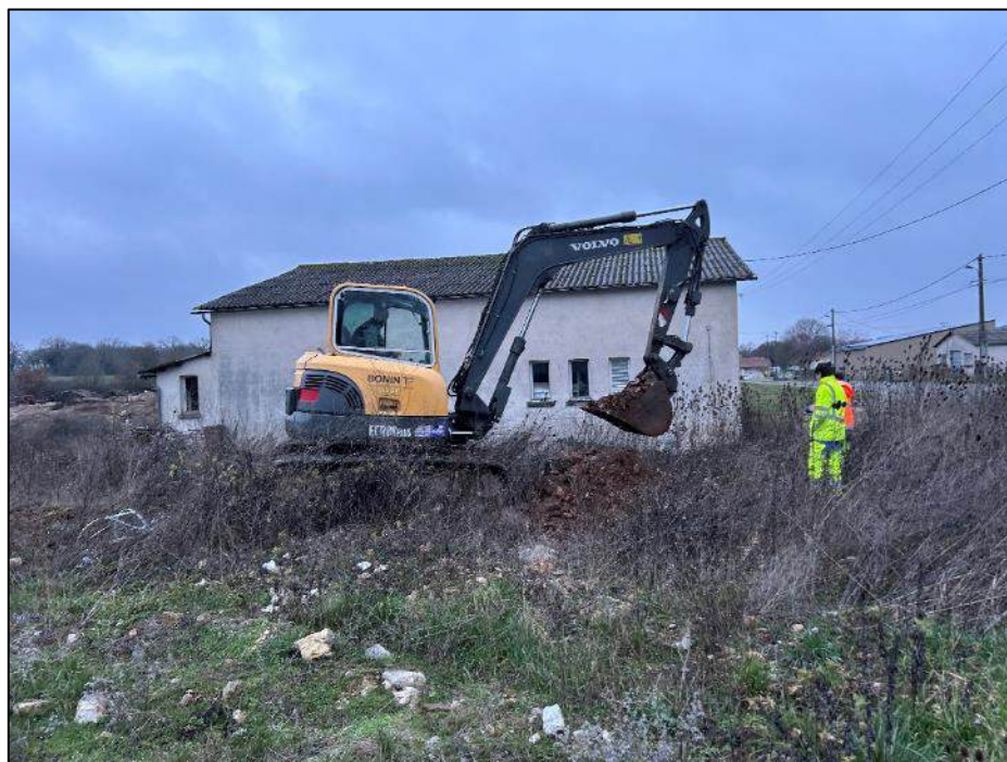
Figure 11 Habitation en limite de propriété Ouest – 08/01/2024.
