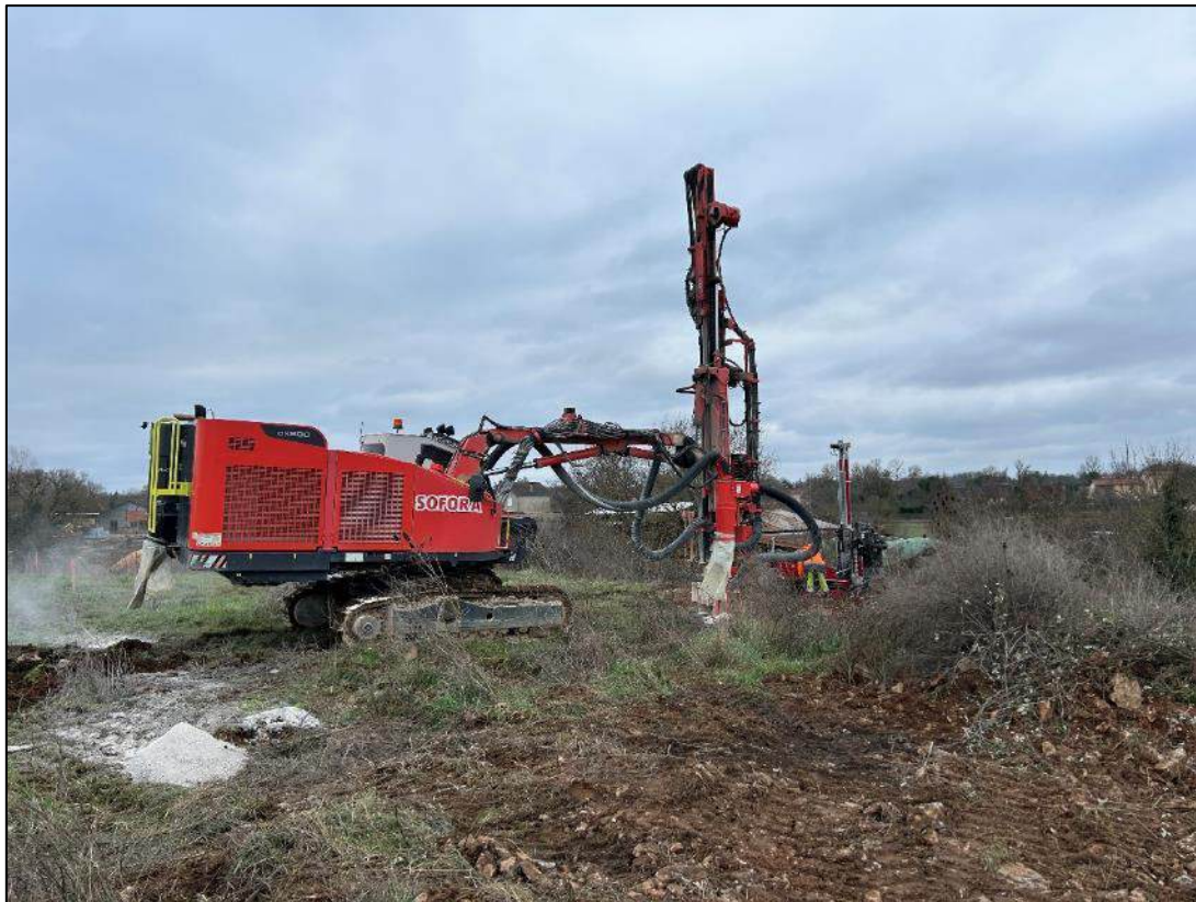
Figure 18 Foreuse de minage lors de la réalisation des forages destructifs le 08/01/2024
