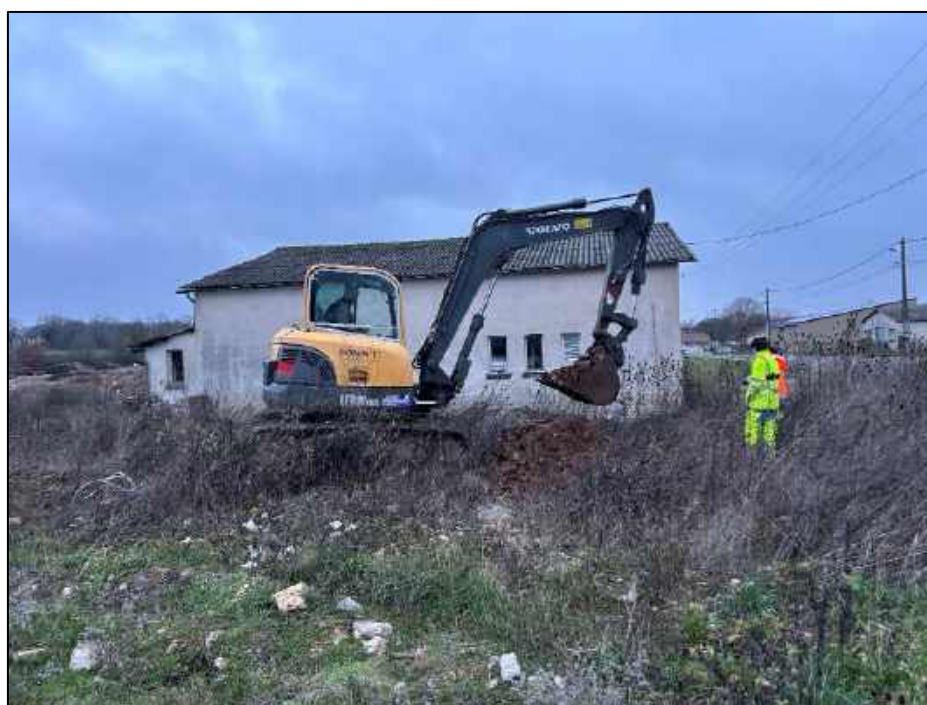
Figure 12 Habitation en limite de propriété Ouest - 08/01/2024.
